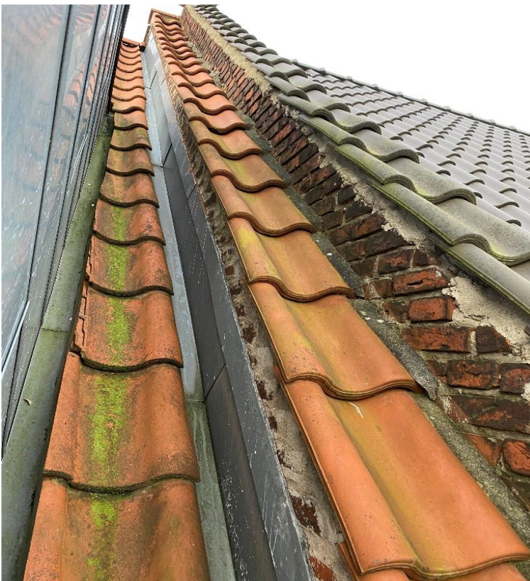
Mod gade. Brandkam i nr. SKG 29 mod SKG nr. 31. Tagbelægning og inddækninger efterses for skader
