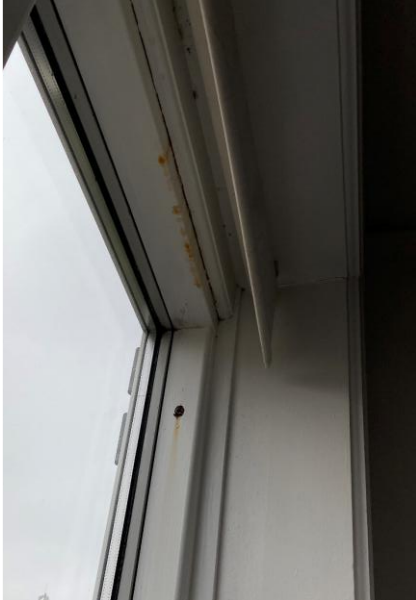
Fugtskadet vindue
