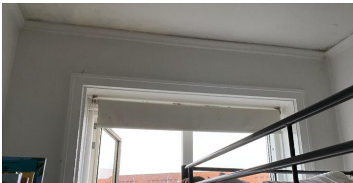
Værelse mod gård, fugt i vindueslysning
