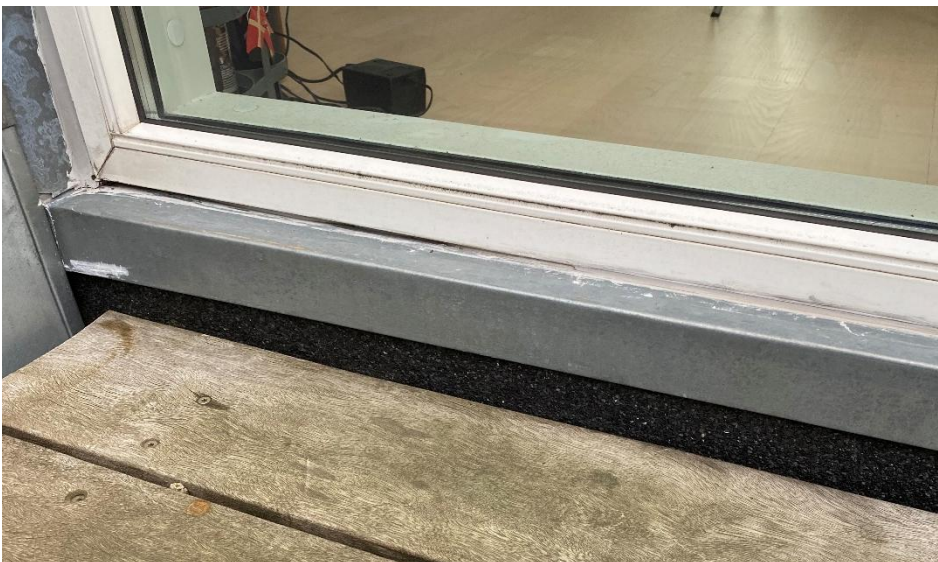
Fuge under vindue og underliggende zink er meget smal, til højre ligger fugen helt ude og lukker for vinduesdræn. Til venstre på billedet herover er fugen forsøgt med at ligge længere tilbage bag dræn. Indvendig er målt forhøjet fugt. Årsag vurderes at være utæt fuge eller komme op fra inddækning på taget.
