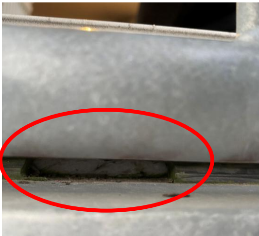
Billede viser fuge under dreje-kip dør, hvor der er fjernet noget af fugen, evt. er der taget en prøve som aldrig er blevet genfugtet.
