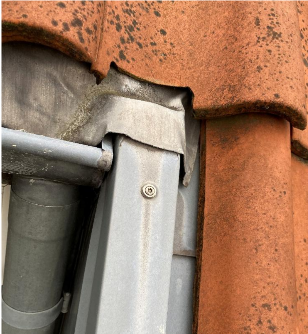
Inddækning over væg
