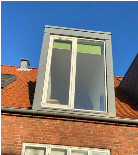
Kvist mod gade med fast vindue og fransk altandør. Kvisttag, tag afvandes mod hoved taget.
