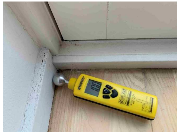
I soveværelse er fodpanel til venstre opfugtet til 100.
