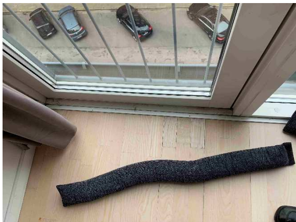
Ved de gående døre ved de franske altaner er der aftegninger efter fugt. Gulv i stue har mindre skade.
