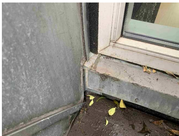
Udvendigt i hjørnerne ses samme fejlkonstruktion som ved de fleste øvrige facader på 5. sal. Her ses venstre side set ude fra.
