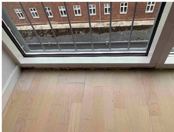
I stue er nyere vinduesparti. Partiet er for nyligt blevet fugtet udvendigt. Her er p.t. ikke forhøjet fugt.
