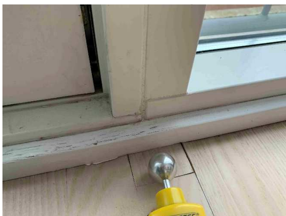
P.t. ingen forhøjet fugt gulv ved fransk altan, men der har tidligere været vand på gulvet.
