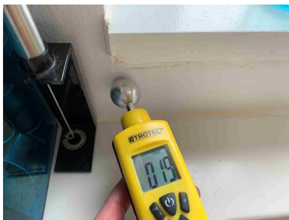
Der er p.t. ikke forhøjet fugt.
