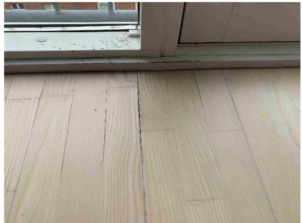
Gulvet buler en del i soveværelset.
