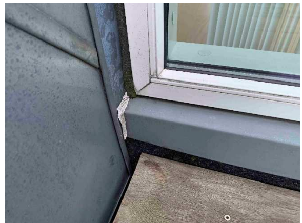
Fuge i hjørne til venstre (højre set indefra). Hjørne er utæt, se fugtmåling på foto ovenfor.
