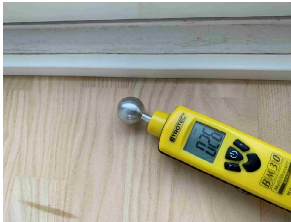
Gulv ved fransk altanparti buler let. Her er lettere forhøjet fugt. Kan skyldes åben dør eller utæt parti.
