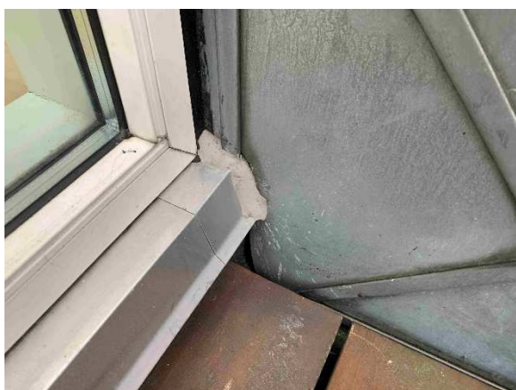
Udførelse til højre set ude fra.
