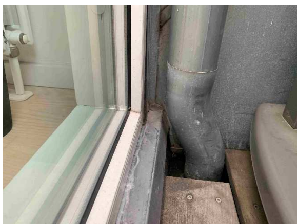
Højre side set ude fra. Det er i denne side, der er målt forhøjet fugt indvendigt.
