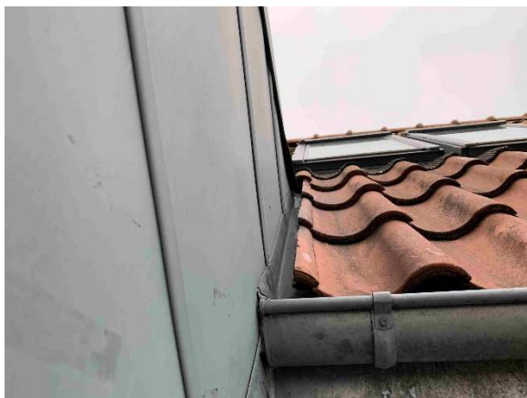
Når facadeparti ændres, skal inddækning langs tagkant ind under den nye zinkfacade.
