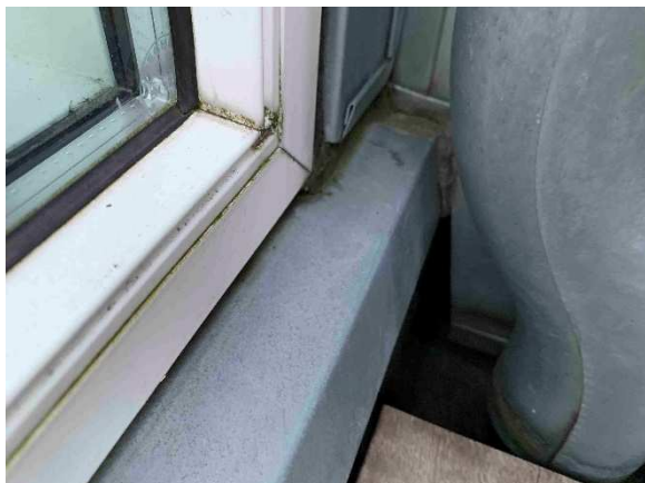
Der er bagfald på zinkinddækning.
