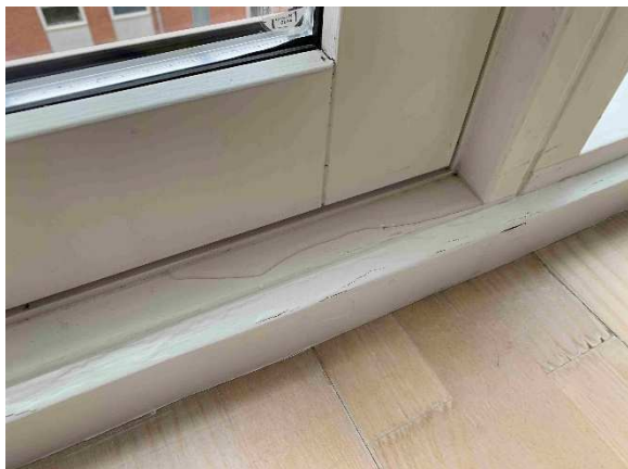
Gulv ved den franske dør i stue har forhøjet fugt.
