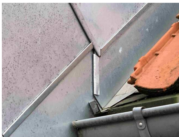
Zinkinddækning ved tag er udført forkert. Denne udførelse er ikke observeret andre steder.
