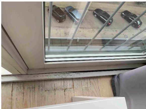
Gulv i soveværelse er ligeledes beskadiget af fugt, og der måles forhøjet fugt. Her er det kun ved den gående dør.
