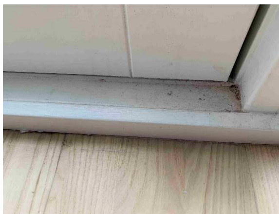
Pga. liste på dørparti er højere end karmen på partiet, tyder det på, at vand løber på karmen og hen mod fodpanel, som omtalt på forrige foto.
