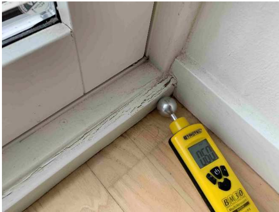
Ved den gående dør i stue er der fald til højre på bundkarmen, som medfølger at fugt og vand ødelægger listen i højre side.
