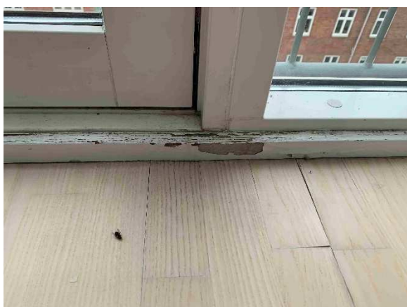
Som forrige foto. Tydelige tegn på, der har været fugtigt, men der er p.t. ingen væsentligt forhøjet fugt.
