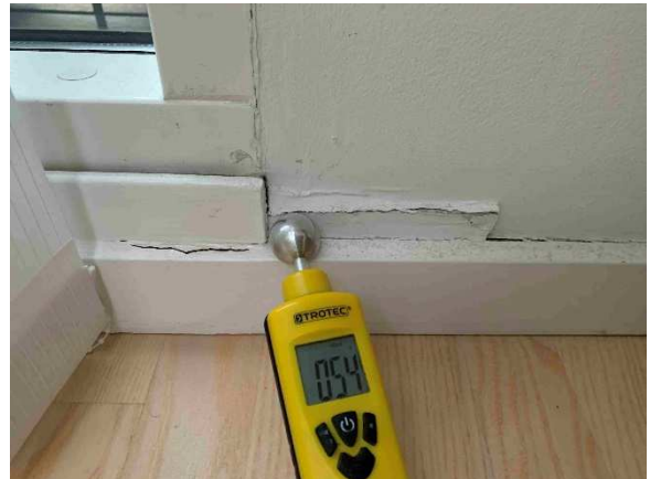
Fugt i højre hjørne mod terrassen er 54, hvilket er for højt.
