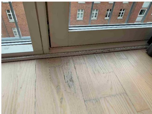
I soveværelset er der skjolder på gulv efter fugt/vand.
