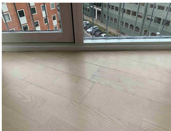
Gulv ved fransk dør i køkken er lettere beskadiget ved samlingerne af det faste parti og den gående dør.
