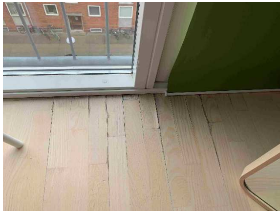
Gulv i soveværelser er ligeledes beskadiget. Evt. utætheder bør undersøges af ejer.
