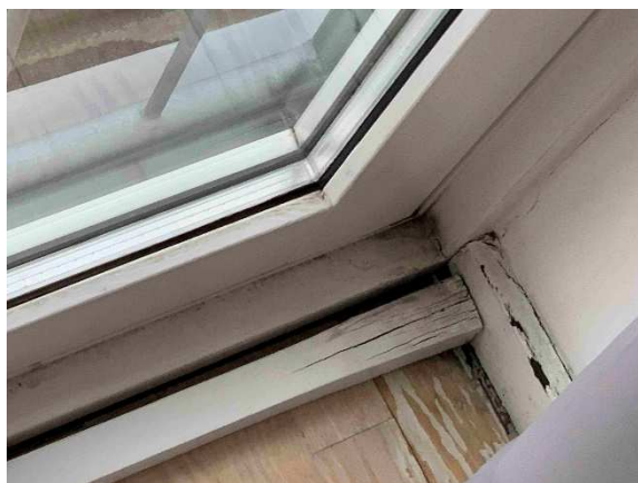
Fodpanel og lister ved den gående dør er fugtskadet.
