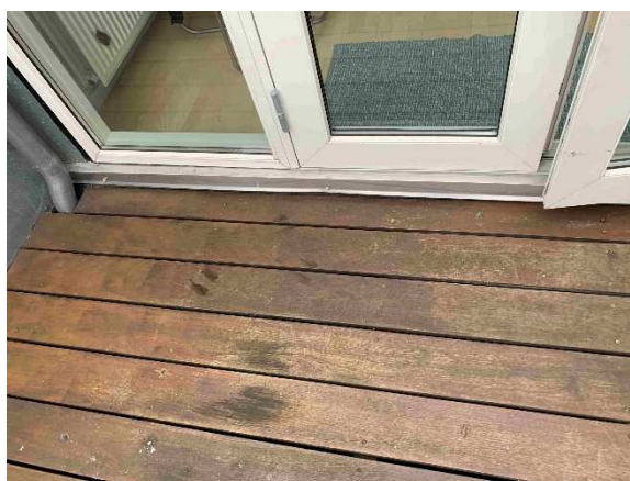
Alu-inddækning som bundskinne bør ændres til zink som i Ourøgade nr. 33, 5. sal.
