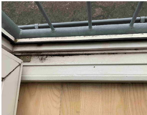
Det formodes at vand trænger igennem den gående dør, løber til venstre og påvirker fodpanelet. Beboer bør undersøge nærmere.
