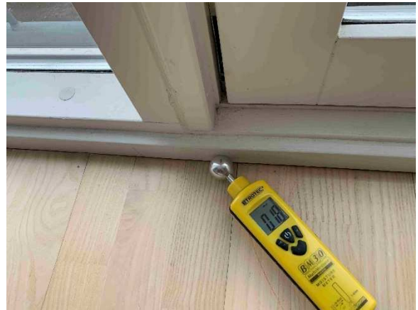
I venstre side af døren i stue er der ikke forhøjet fugt.
