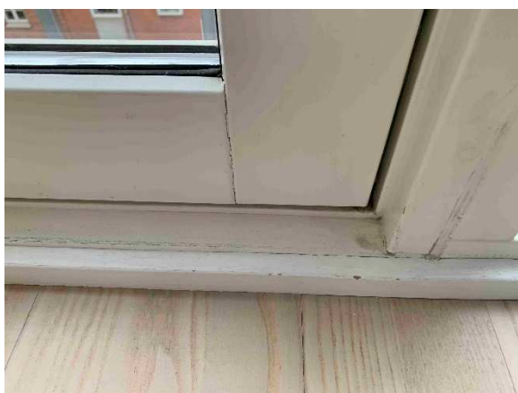
Ved fransk altandør i stue er tydelige skjolder efter vand.
