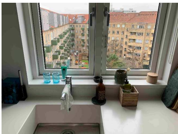
Beboer oplyser, at der gentagende gange har været problemer med fugt i hjørnet af køkkenvinduet. (se foto nedenfor)
