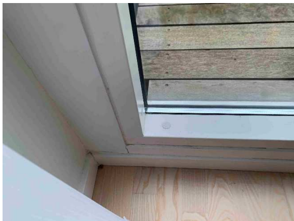
I hjørne til venstre er der p.t. ingen utætheder.
