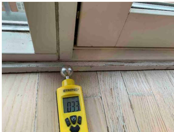
Ved overgangen mellem det faste parti og den gående franske altandør, er der forhøjet fugt. Målingen er her 33.
