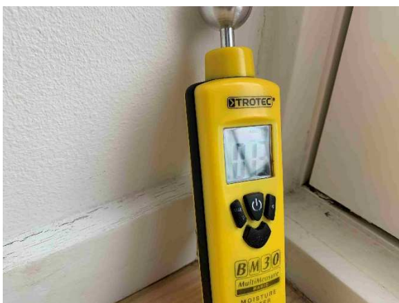
Der er ikke forhøjet fugt i væggen bag fodpanelet.
