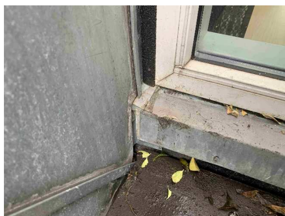
Udvendigt er udført forkert hjørneløsning med fugt. Bør ændres om i Ourøgade nr. 33, 5. sal.
