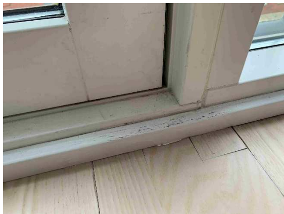
Der er skjolder på gulv i stue ved fransk altan.
