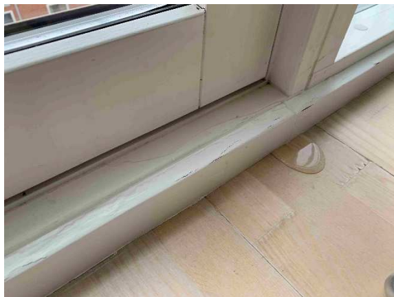
Ved berøring på undersiden af den gående dør (i lukket tilstand) løber vand ud på gulvet på trods af det er 2 dage siden, det har regnet.
