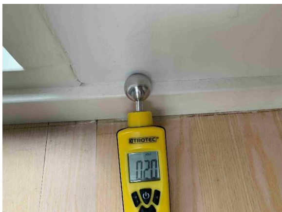
Ved terrasseparti til højre (set indefra) er der ikke forhøjet fugt.
