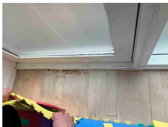
Ved det franske dørparti i stue har gulvet forhøjet fugt hele vejen og ikke kun ved den gående dør.
