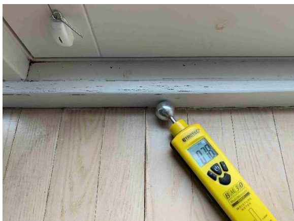
Gulv ved den franske dør i soveværelset er væsentligt forhøjet med en måling på 78.
