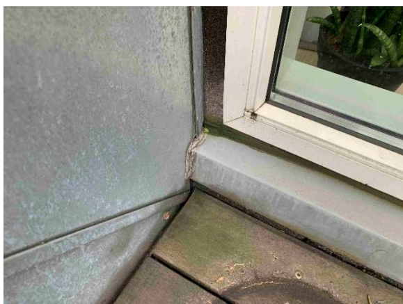
Udvendigt i hjørnerne ses samme fejlkonstruktion som ved de fleste øvrige facader på 5. sal. Her ses udførelse i venstre side set udefra.
