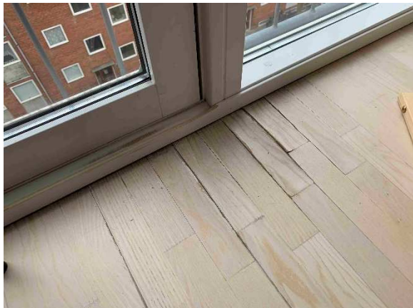
Gulv i stue buler en del. Her kan være tale om utæt dør eller dårlig samling mellem det faste og det gående parti.
