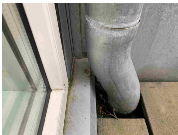
Udførelse til højre set ude fra.
