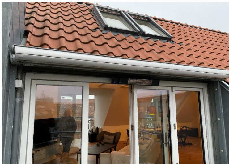
Hele vinduespartiet er udskiftet.
