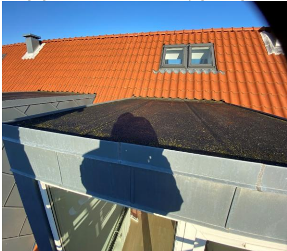
Registrering af udskiftning af vinduesparti i stue.
