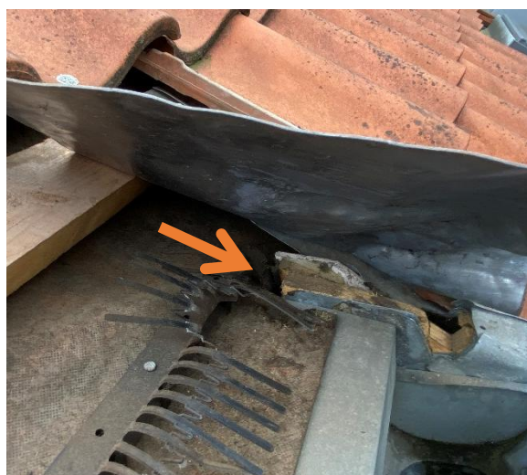
Bly afdekning over bræddevæg er monteret på overside lægter. Vand som kommer ind på undertag, kan løbe ned i væg bag vægens zinkbeklædning.
