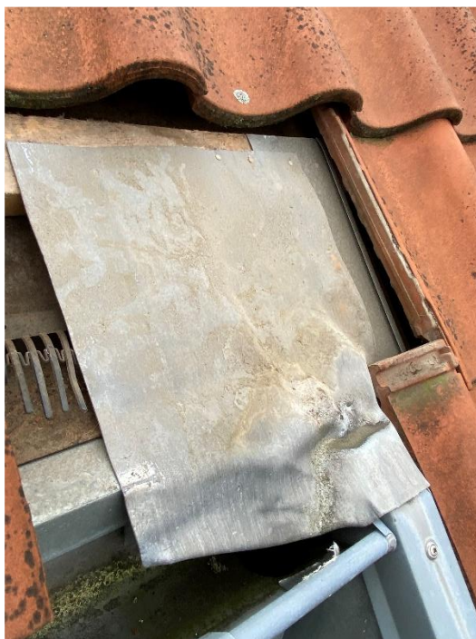
Bly afdekning over bræddevæg er monteret på overside lægter. Vand som kommer ind på undertag, kan løbe ned i væg bag vægens zinkbeklædning.
