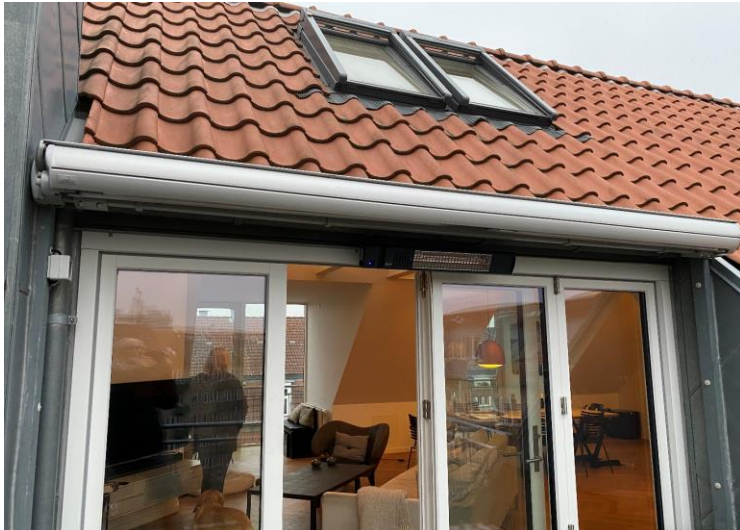
Hele vinduespartiet er udskiftet.
