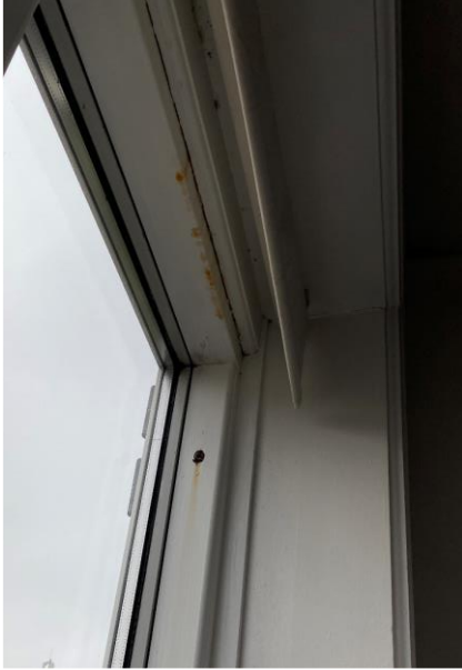
Fugtskadedt vindue
