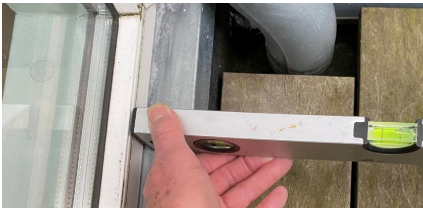
Den tidligere udskiftet zinkinddækning under vinduesparti har bagfald.
