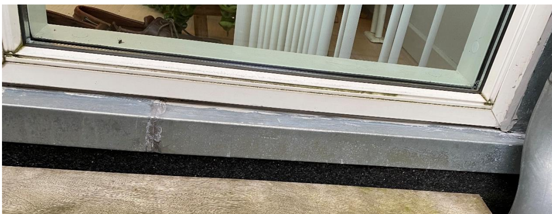
Den tidligere udskiftet zinkinddækning under vinduesparti har bagfald.
