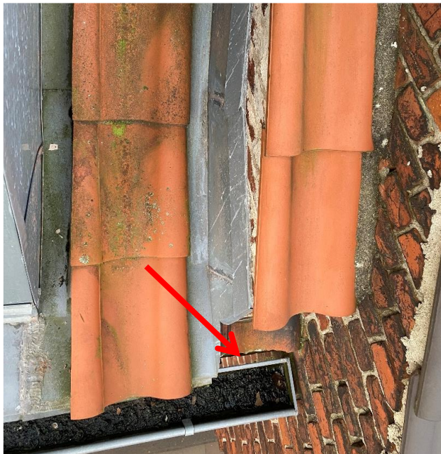
Mod gade. Brandkam i nr. SKG 29 mod SKG nr. 31. En tagsten er knækket og tagrende fyldt med møg.
