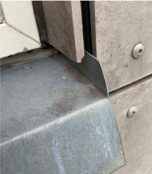
Sålbænk tilslutning underside vindue.
